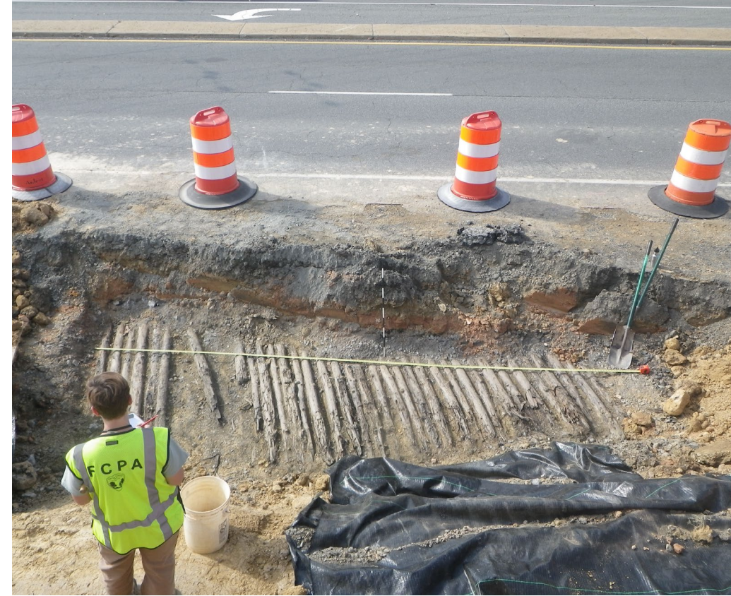
Rustbädd av cederträd från amerikanska inbördeskriget (1860-talet) under Ox Road, Fairfax County, Virginia, USA. Källa: Fairfax County Park Authority
