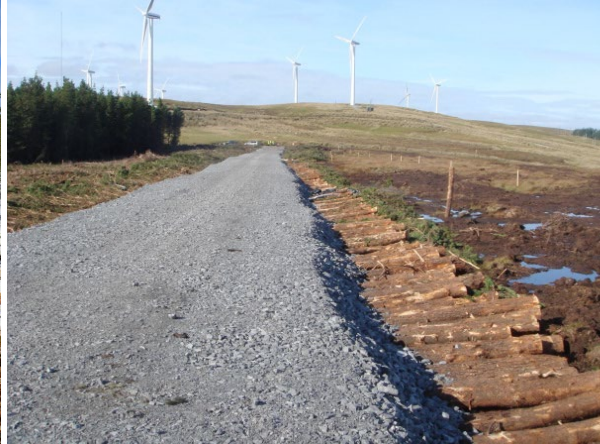
Grusbelagd kavelbro, tillfartsväg vindkraftspark. Källa: Roadex Network
